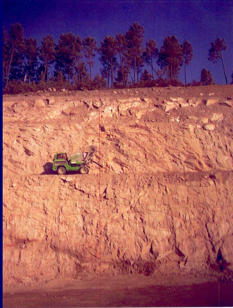
22+025 (antes de executar dreno e colector)
